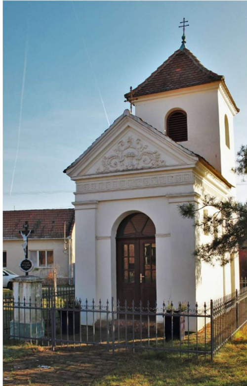
Obr. 20 Kaple sv. Michala Zdroj: webové stránky obce
