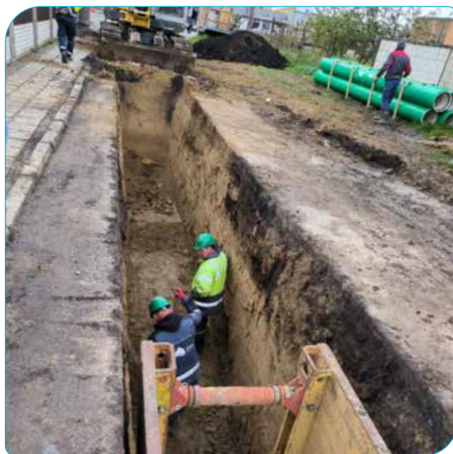
Lednice – ul. Komenského, rekonstrukce kanalizace a vodovodu
