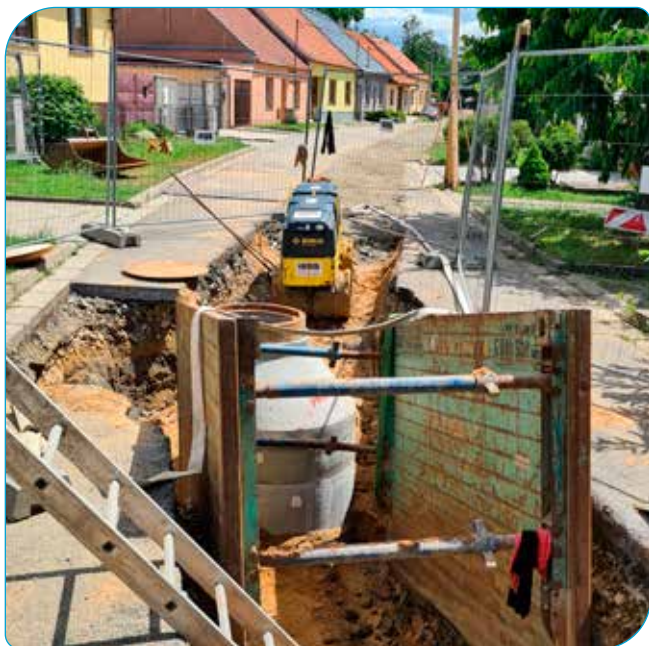
Pohořelice – ul. Brněnská, rekonstrukce kanalizace
