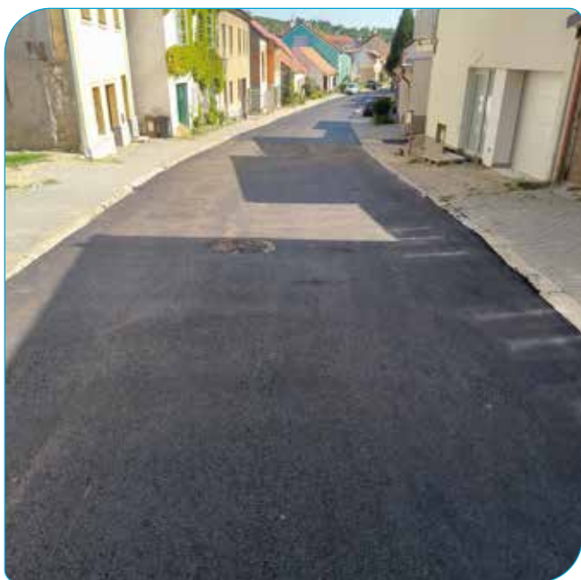
Mikulov – ul. Na Jámě, rekonstrukce kanalizace a vodovodu
