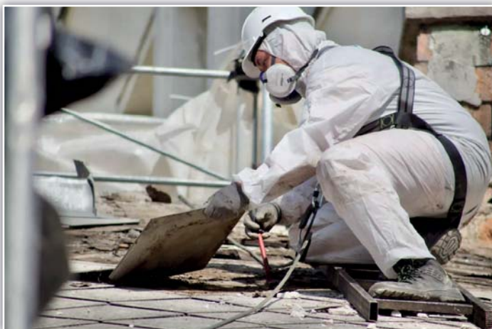
Likvidace azbestové střechy
